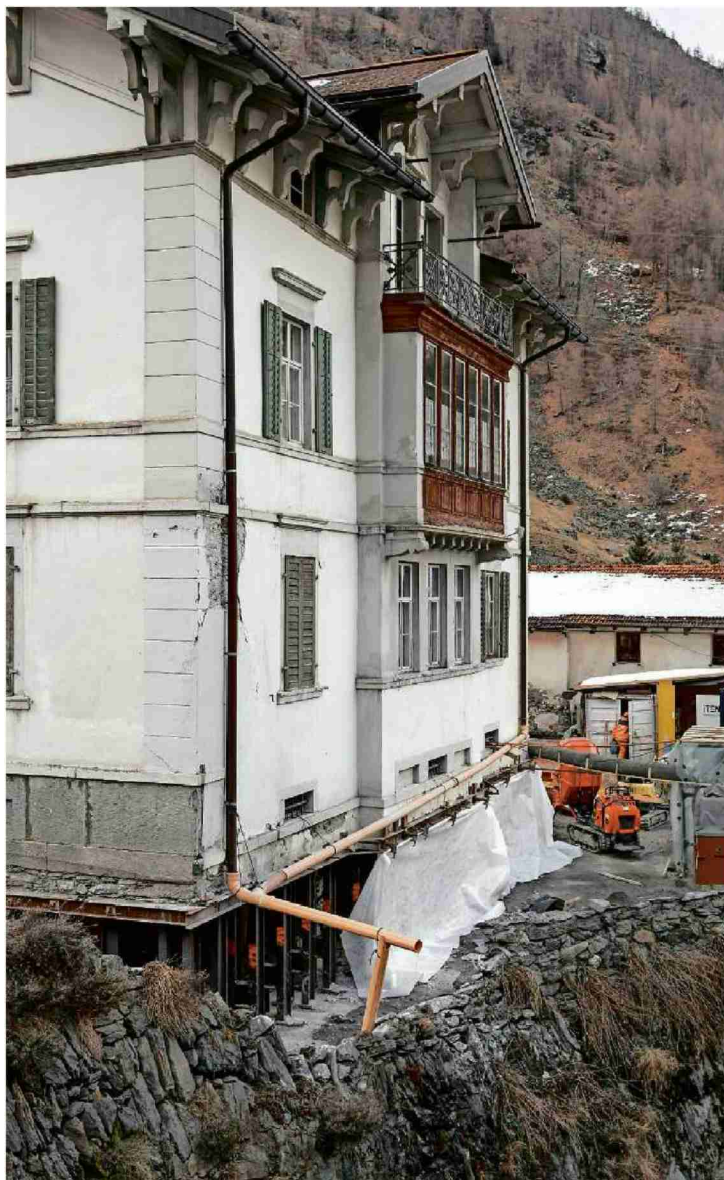
In Mulegns hat sich seit letztem Oktober einiges getan. In nur wenigen Monaten soll die Verschiebung der Weissen Villa erfolgen. Bild Benjamin Hofer
