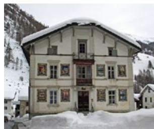
Rechts: Die «Weisse Villa», eine ehemalige Zuckerbäckerei, wurde acht Meter talwärts verschoben.
