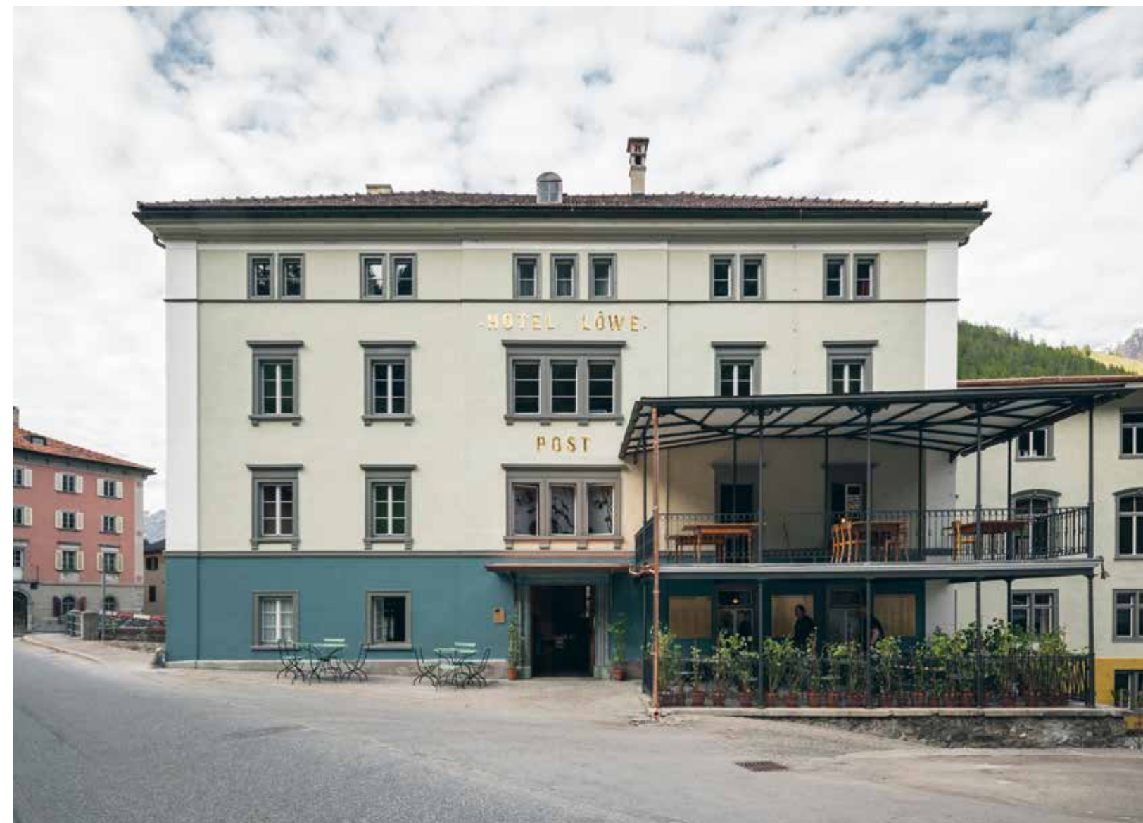
Die Fassaden wurden umfassend restauriert. Die hölzernen Fensterlaibungen, der Fassadenschmuck und die filigrane Terrasse wurden aufwendig restauriert. Das sanfte Grün der Fassade entspricht der ursprünglichen Bemalung des Post Hotel Löwe.
