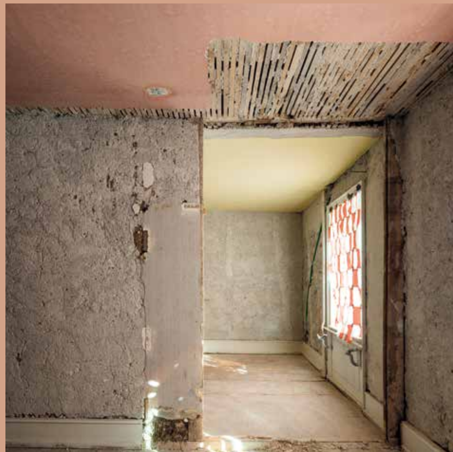
Blick in die Petersburger Suite. Die aufwendige Schadstoffsanierung hat Deckenbemalungen und Original-Fussböden zutage gefördert.
